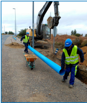
Maneras correctas de manipular y transportar las tuberías
