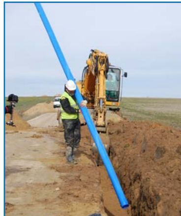
Maneras correctas de manipular y transportar las tuberías
